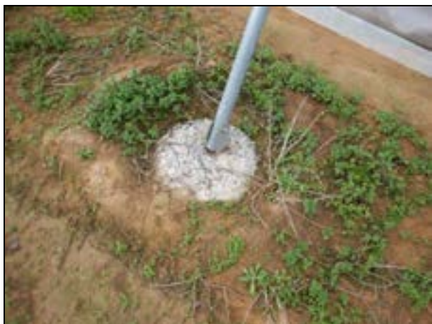
Figure 5 : Pieux d'implantation des poteaux
