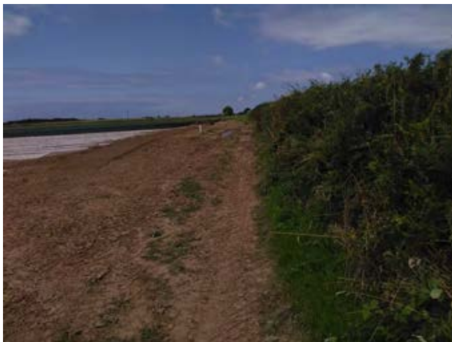
Photo 20 : Talus végétalisé 4 (vue vers le nord)
