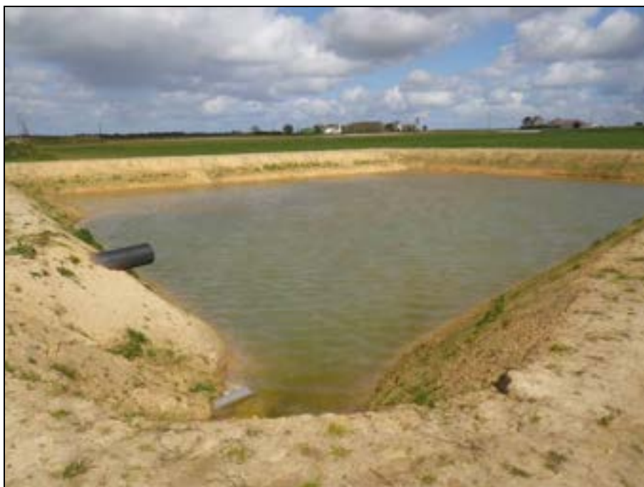
Photo 2 : Bassin de régulation des eaux pluviales existant
