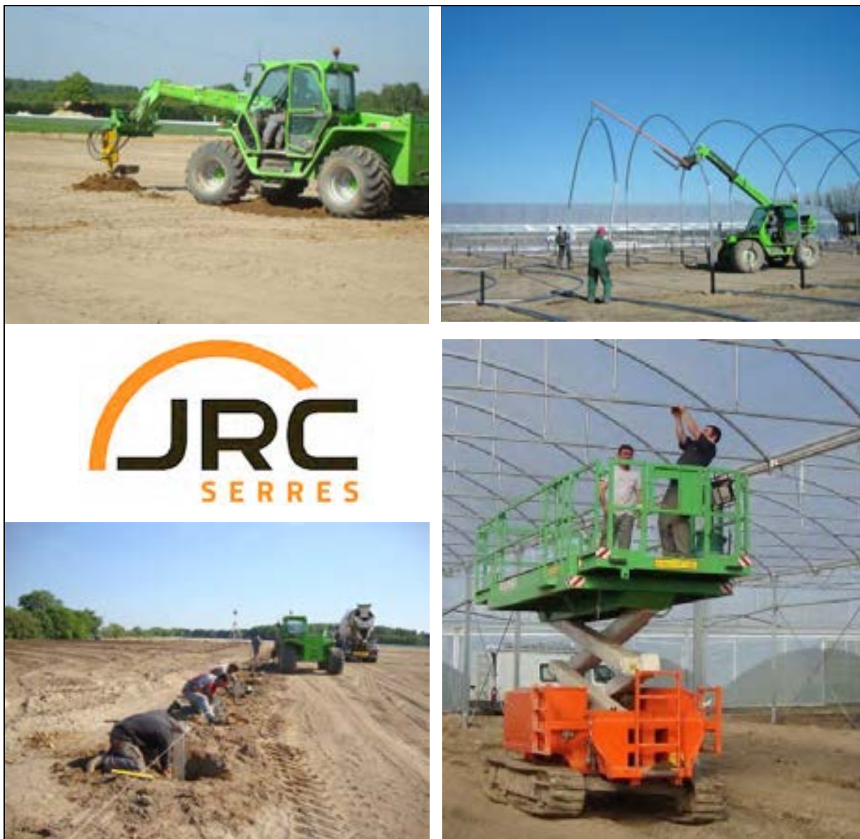
Figure 7 : Etapes de montage des serres (source : JRC Serres)
